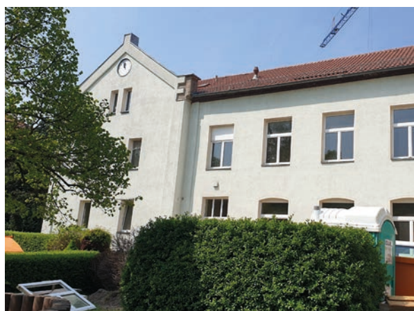
📷 „Alte Schule“ während der Sanierungsarbeiten
